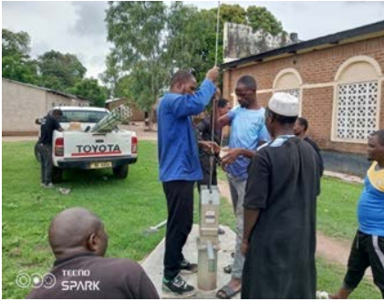
Harry Nyirende Borehole
