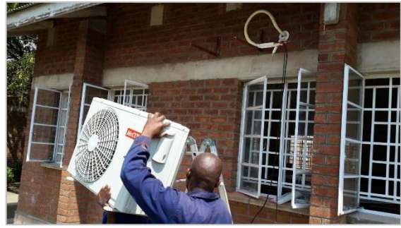
Installing the external air con unit
