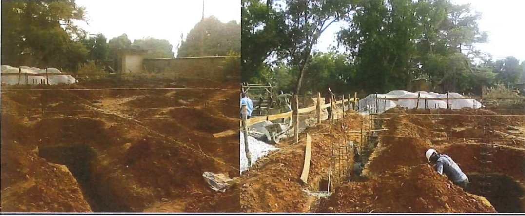
Début de travaux
